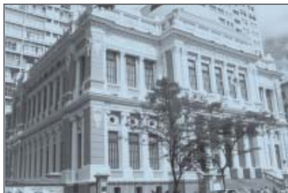
Palácio da Justiça "Rodrigues Campos", sede do Tribunal de Justiça de Minas Gerais, construído em 1910.
